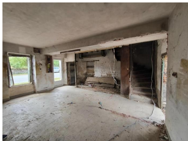
Figure 3- Photo de l'intérieur RDC - Aile Ouest
