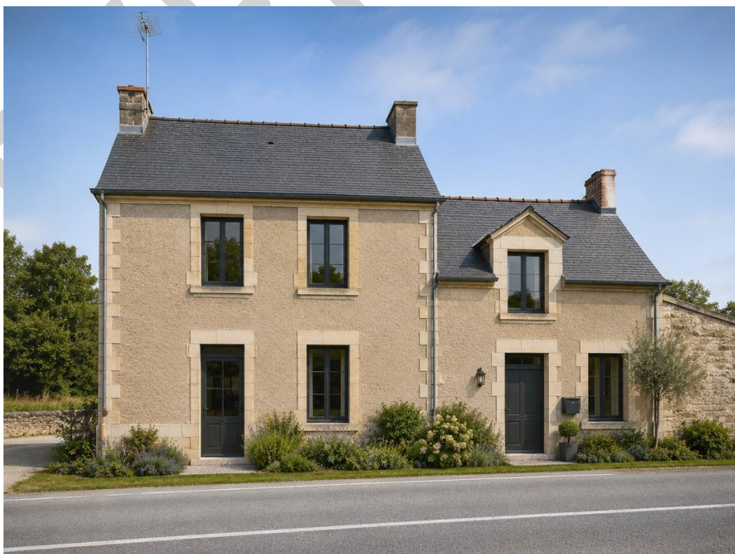
Façade Sud-ouest – Après travaux
