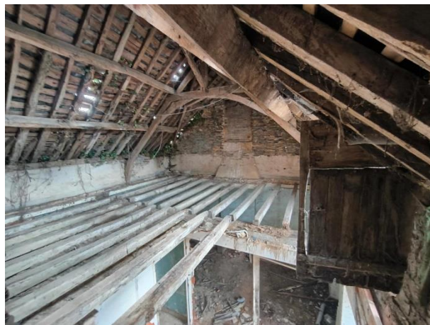
Figure 5 - Photo de l'intérieur solives des Combles - Aile Est
