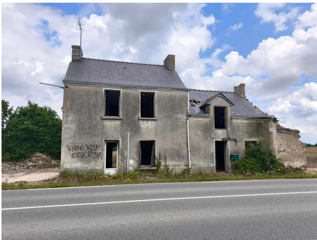
Façade Sud-ouest – Avant travaux
