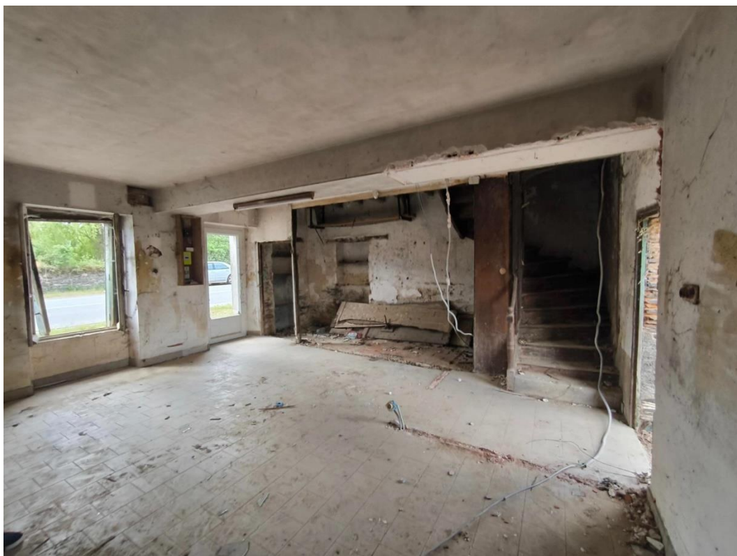
Intérieur du Rez-de-chaussée (aile Ouest) – Avant travaux
